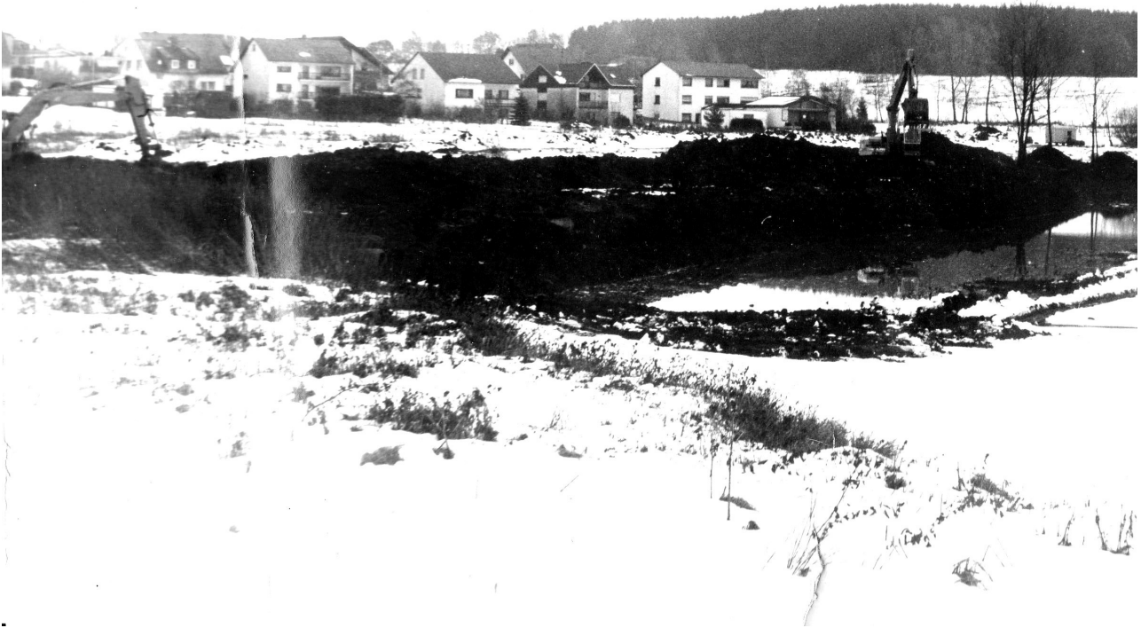
Abbildung 4: Tiefbauarbeiten am HRB Wiesensee (Segelhafen) 1986
