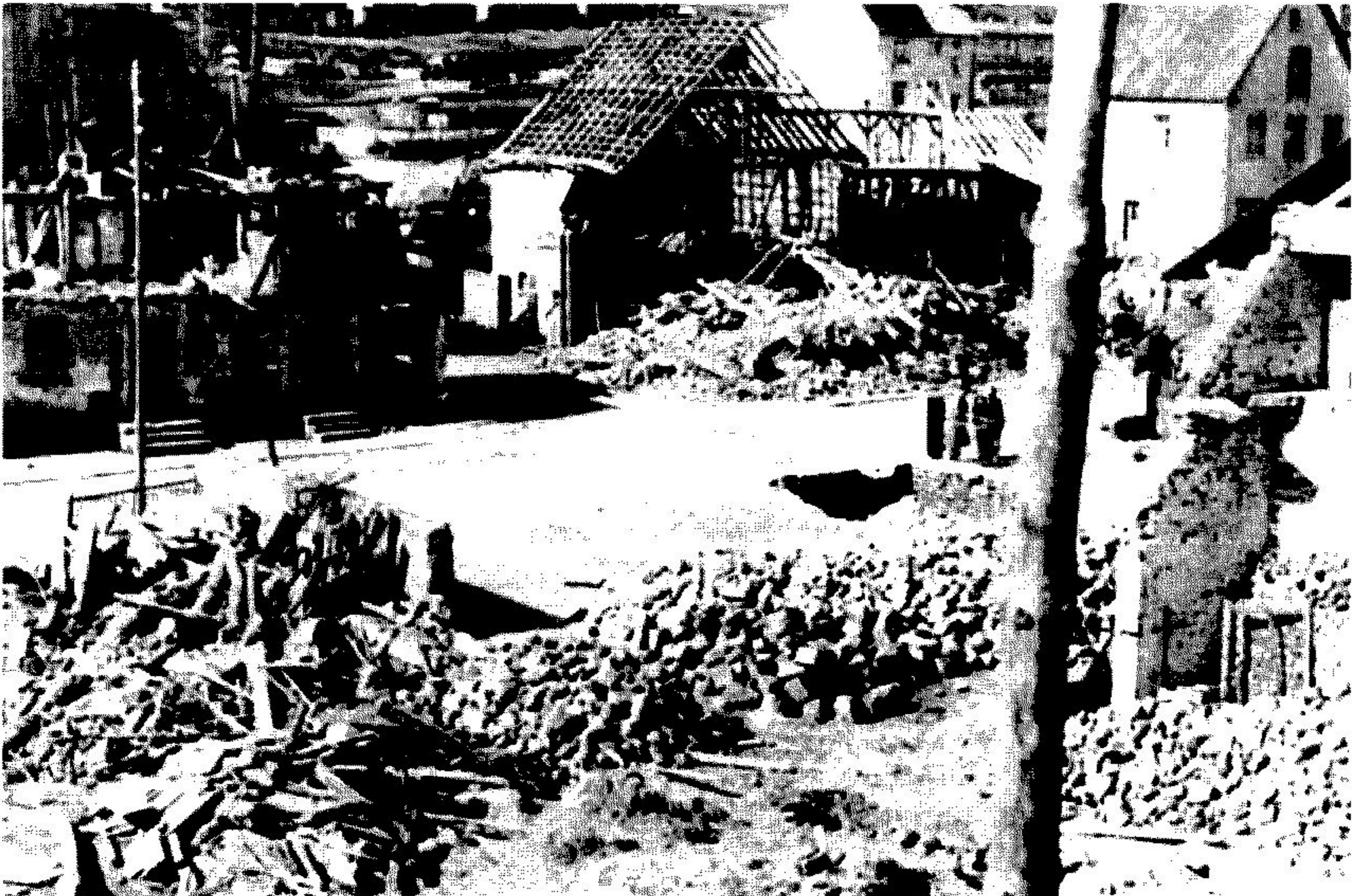
Bombenangriff auf Westerburg am 20. 3. 1945 Foto ca. 20. 8. 1945 von Hermann Clauß Blick von der Mansarde des Hauses Clauß (2) in der Sackgasse Nr. 2 über die Grundstücke Weinehl (rechts) und Löhr (links) zur Neustraße mit der Abzweigung „Zum Neumarkt“ („Millewies“)
