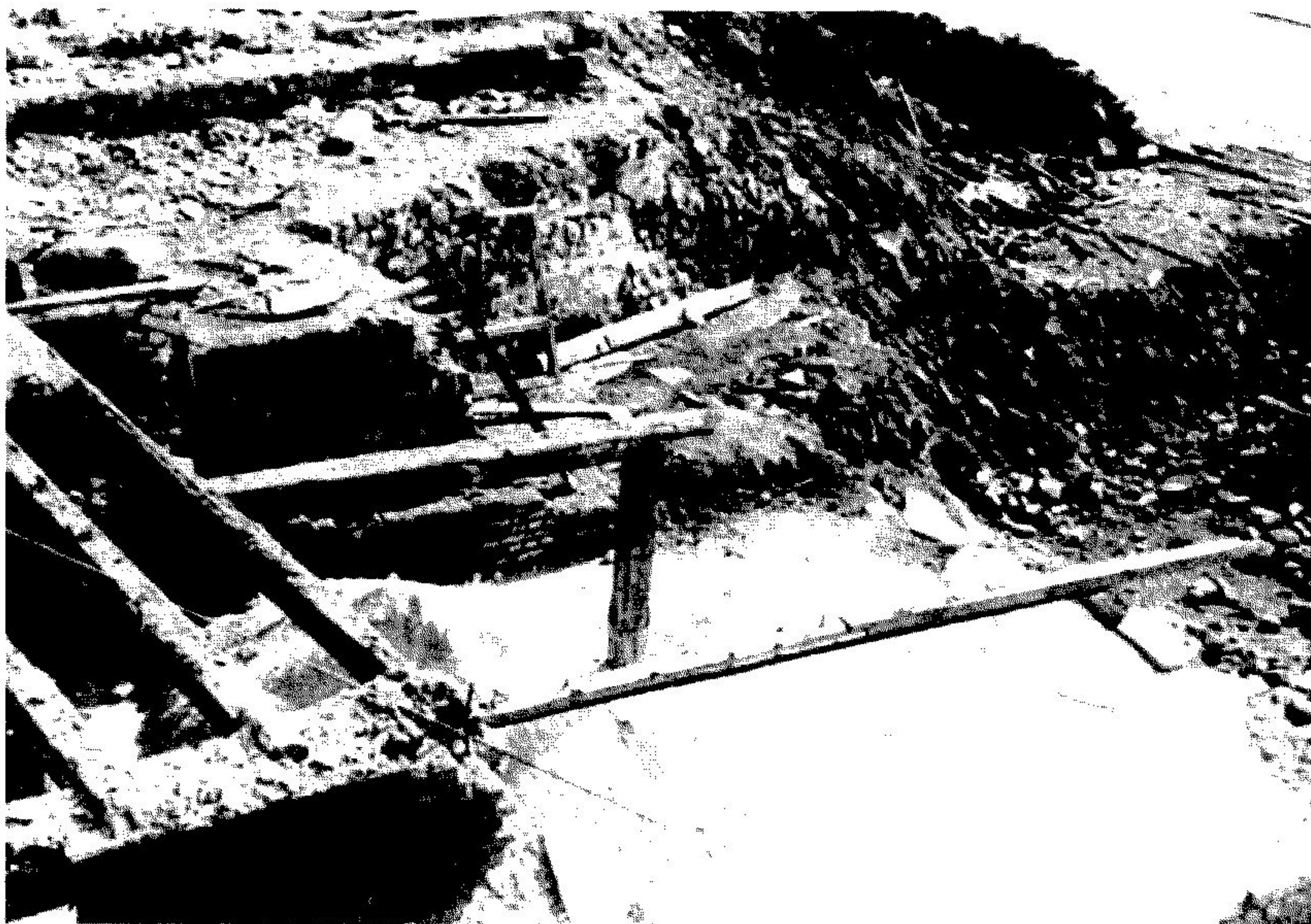
Bombenangriff auf Westerbург am 20. 3. 1945 Foto ca. 20. 8. 1945 von Hermann Clauß jun. Blick von der Mansarde im Haus Clauß (2) in der Sackgasse Nr. 2 auf das vom Schutt befreite Eckgrundstück (Haus Clauß (1) an der Adolfstraße Nr. 3 / Sackgasse (früher Lebensmittel- geschäft, später Volksbank, heute?) Todesstelle von Hermann Clauß sen. Rechts oben: ein kl. Stück von der Adolfstraße sichtbar.
